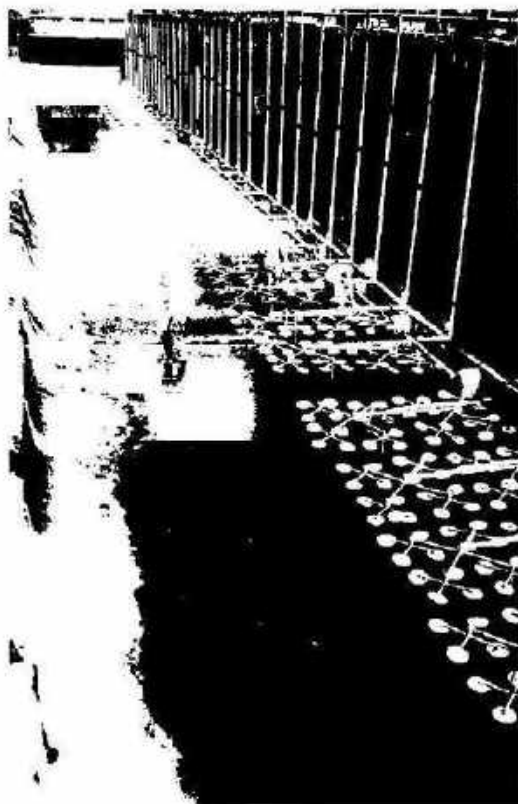
Рис. 1.69. Двойные пластиковые аэраторы, установленные пристенно, занимающие половину поверхности дна коридора аэротенка. Очистные сооружения г. Муром
