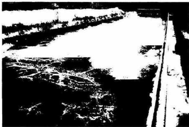
Рис. 1.68. Равномерное удовлетворительное бурление иловой смеси в аэротенке. Курьяновская станция аэрации, г. Москва
