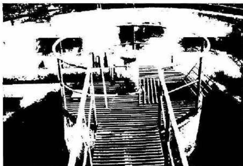
Рис. 1.13. Горизонтальная песколовка с круговым движением воды
