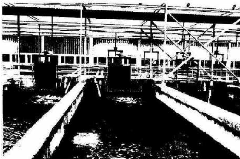
Рис. 1.25. Водораспределительные щиты на входе в горизонтальную песколовку, расположенные над приемком. Люберецкая станция аэрации
