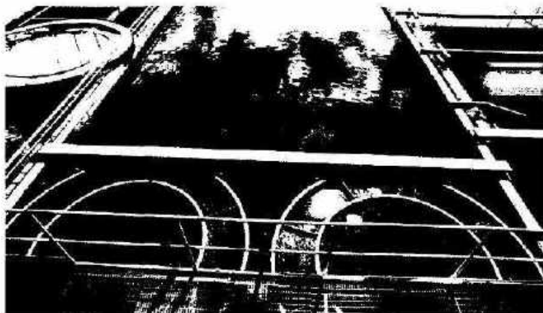
Рис. 1.48. Две камеры флокулообразования, расположенные над приемком горизонтального отстойника
