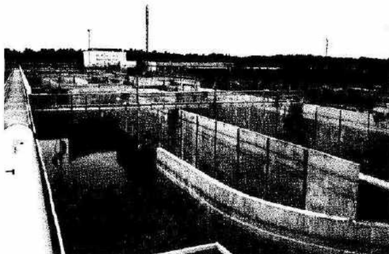
Рис. 2.35. Погружные «банановые» мешалки (производства фирмы Flugt), установленные в аноксидной зоне аэротенков на сооружениях г. Рига
