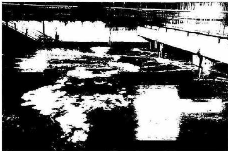
Рис. 1.79. Пенообразование в усреднителях, вызываемое присутствием СПАВ в сточных водах очистных сооружений г. Липецка
